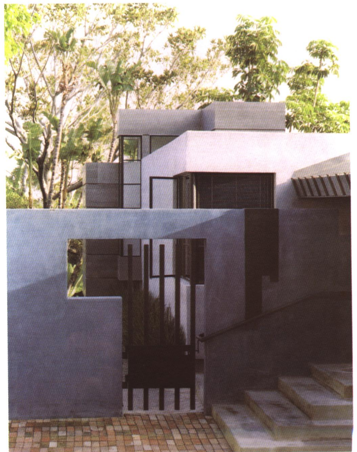
安安戈·伯利住宅 入口处外观
