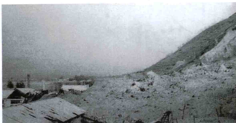
29. 西安新型墙体材料厂黄土滑坡（1990年4月11日），摧毁厂房
