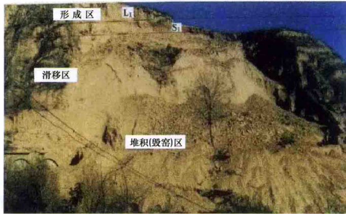
32. 张裂-滑移式黄土崩塌 (清涧县师家原则乡卢湾村)
