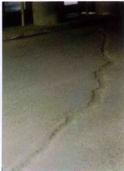
41. 地裂缝发生明显的错落
