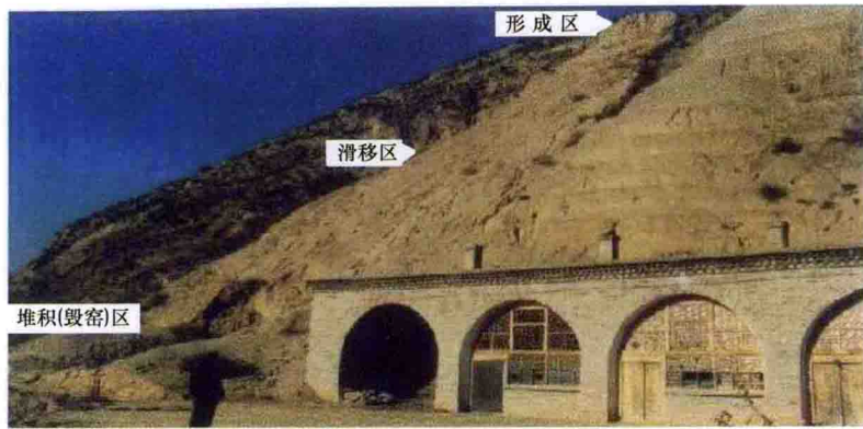
31. 张裂-滑移式黄土崩塌 (子长县黄家川)
