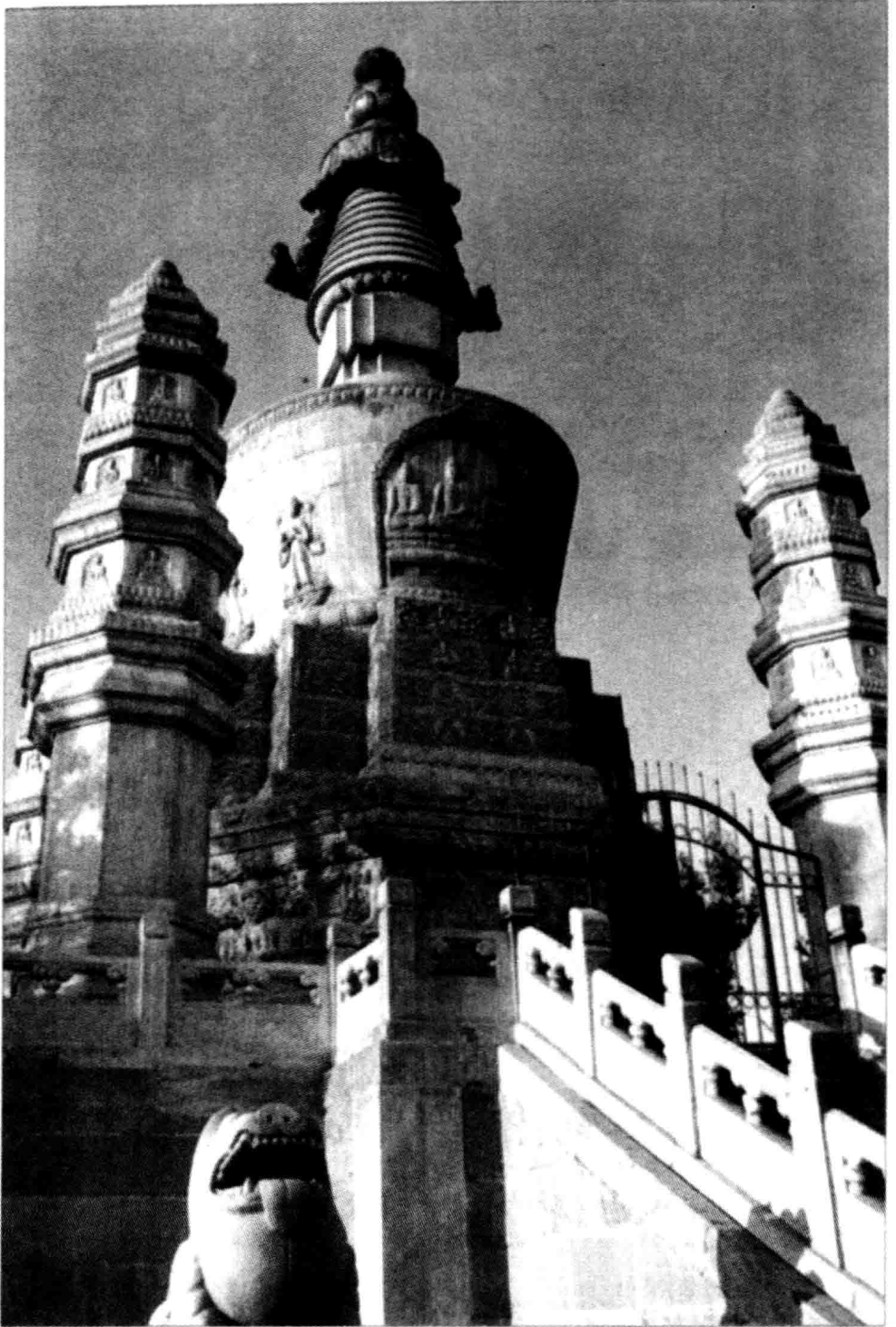
清高宗为纪念六世班禅在北京西黄寺修建的清净化城塔
