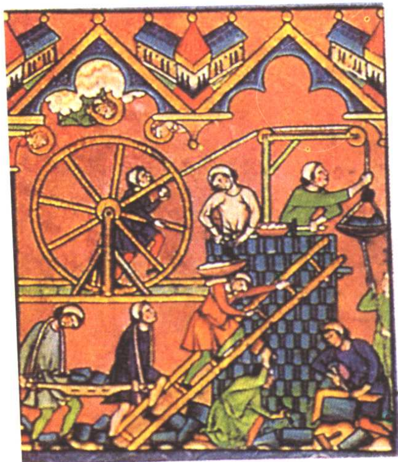
建筑施工情景。选自大约1250年作的一本插图的法文本《圣经》。请注意踏车和踏车上的轮子、绳子和滑轮；利用这些轮子、绳子和滑轮把装满石头的筐筐提到施工平面。（摩根图书馆）
