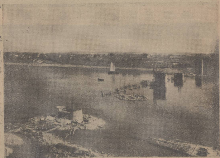
湘江大橋破壞及工程進行情形
