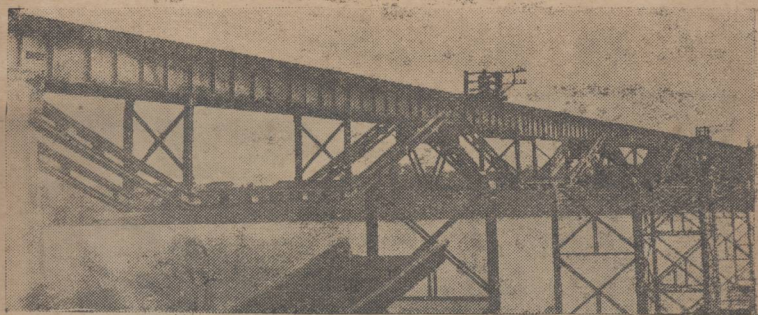
柳州大橋破壞前全圖
