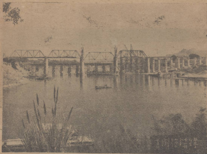
錐容正橋裝吊工程全景
