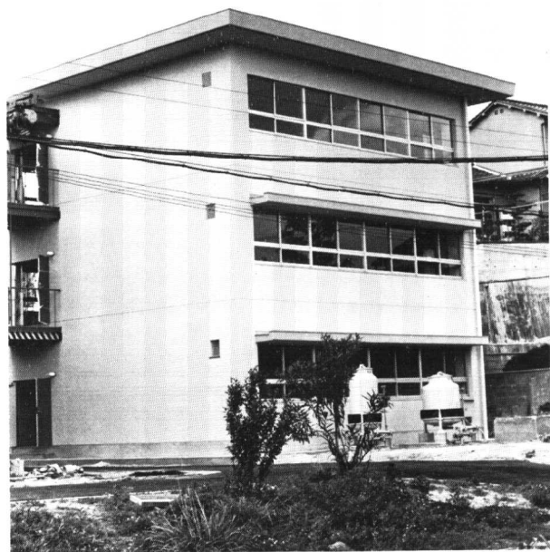
第1部電池実験棟
