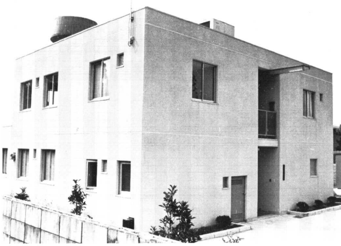
第2部生体工学実験棟
