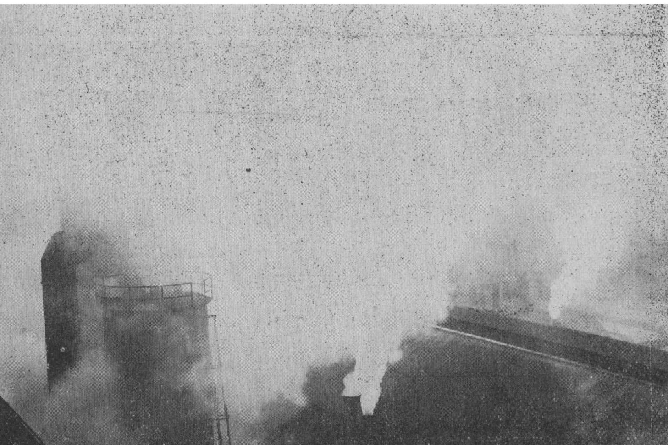
オイルセール工場
