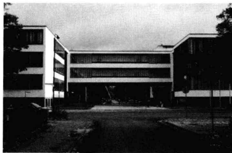
デッソウバウハウス外観正面
