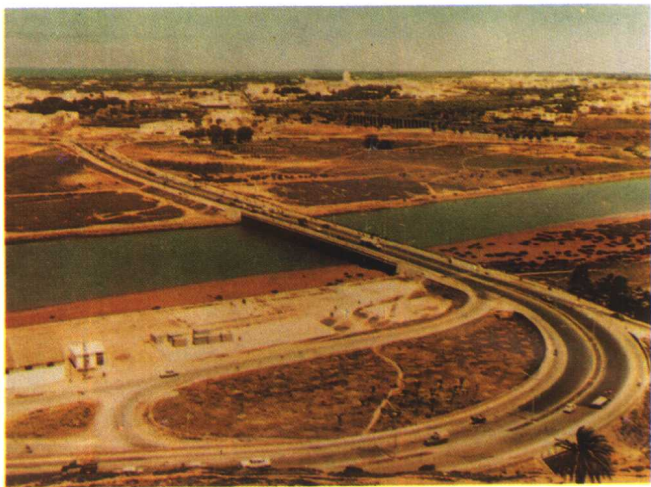
首都郊外的现代化公路
