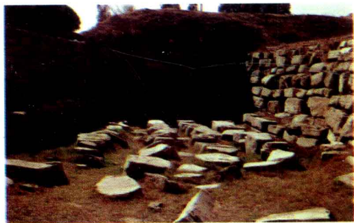
齐故城排水道口
