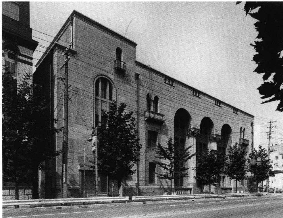
住友銀行横浜支店 Sumitomo Bank Yokohama Branch
