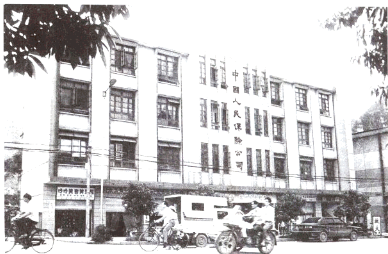
保险公司宜州市支公司办公楼
