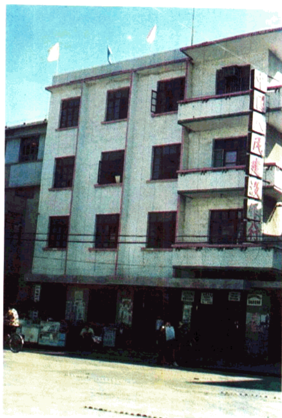
建设银行宜州市支行办公楼
