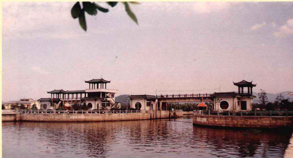
接山口防洪控制工程
