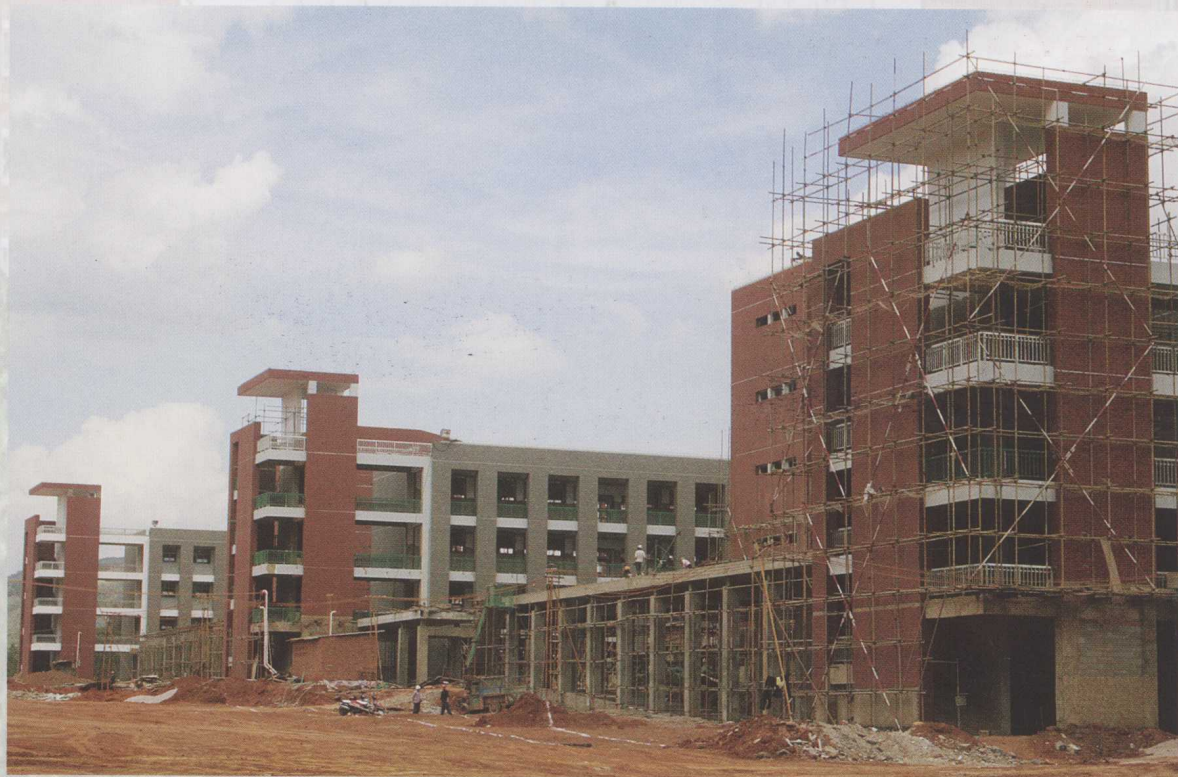
呈贡校区在建工程
