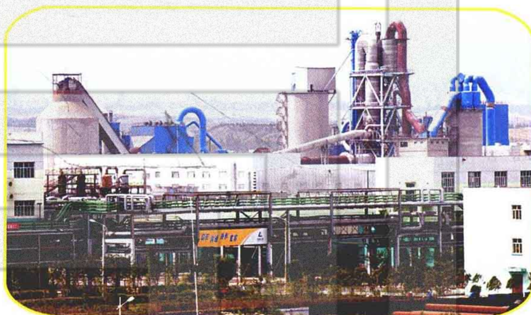
电石渣制水泥循环经济项目
