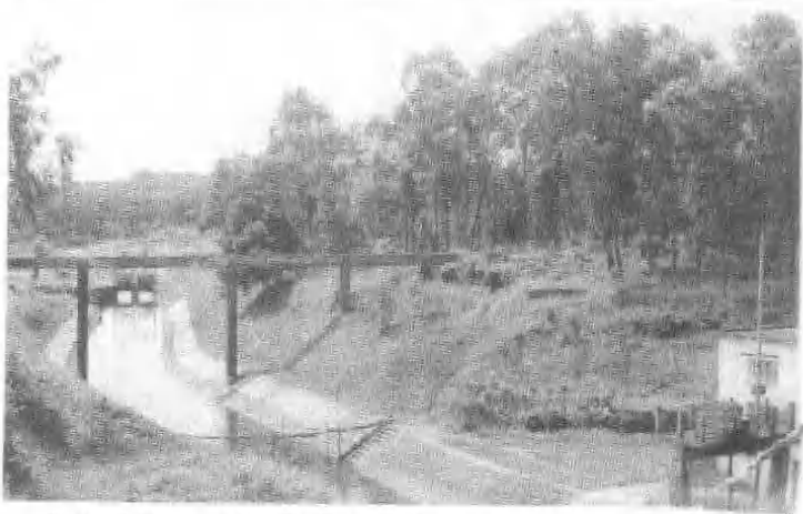
图为：水天一色的福山水库和水库出水口渠道
