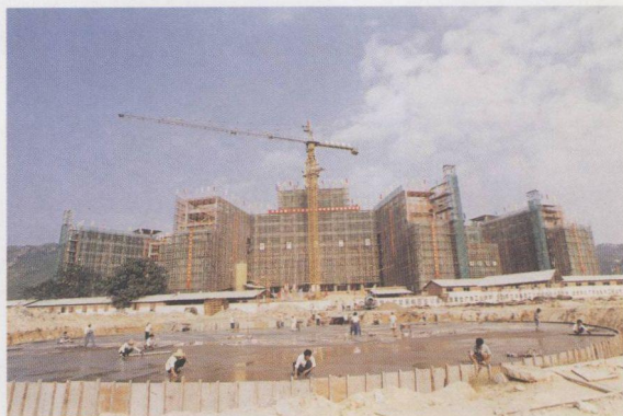
▲在建中的龙洞新校区教学大楼
