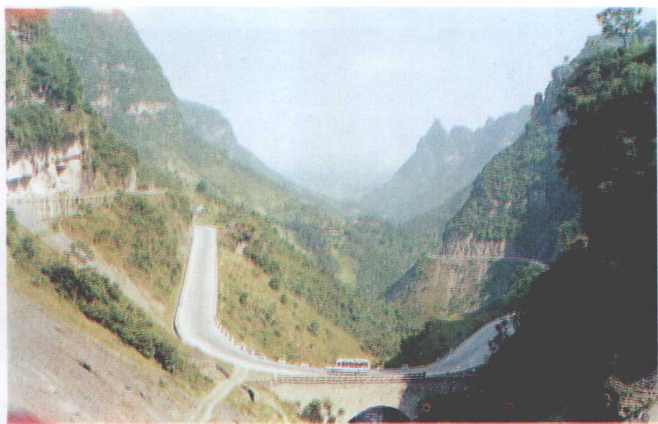
改造后的国道 319 线梅子关路段。
