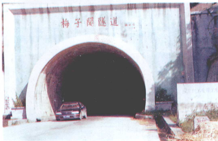
建成后的 梅子关隧道。
