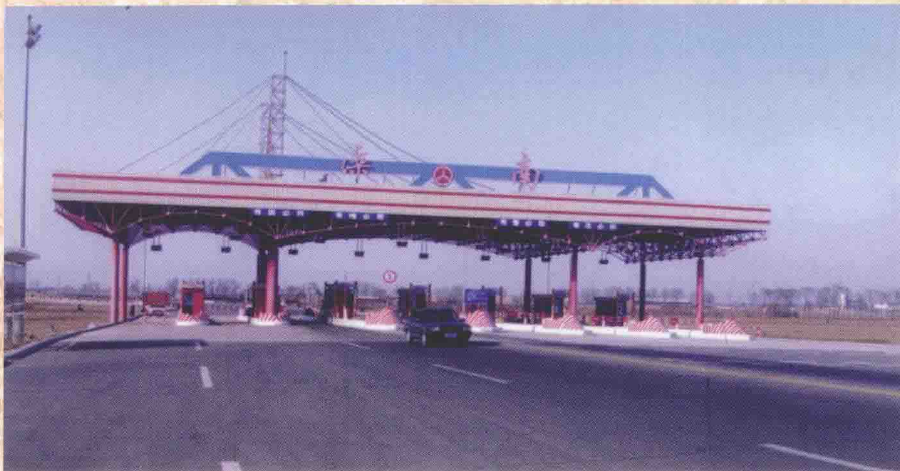
◀ 唐(山)(京唐)港高速公路滦南出口
