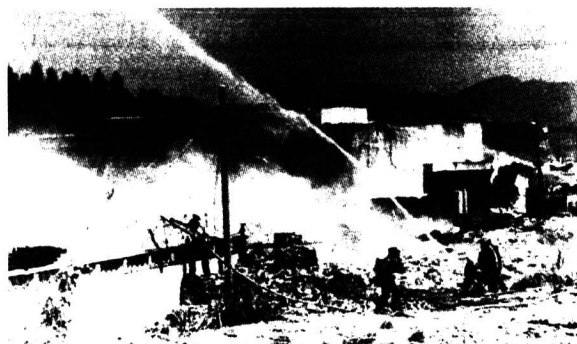
1993年8月5日，抢险救火现场片断
