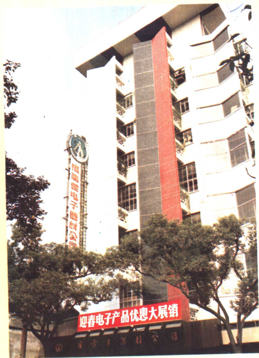
福建省电子工业贸易中心大楼。
