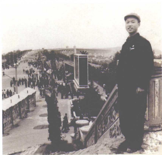
1967.10 武汉长江大桥
