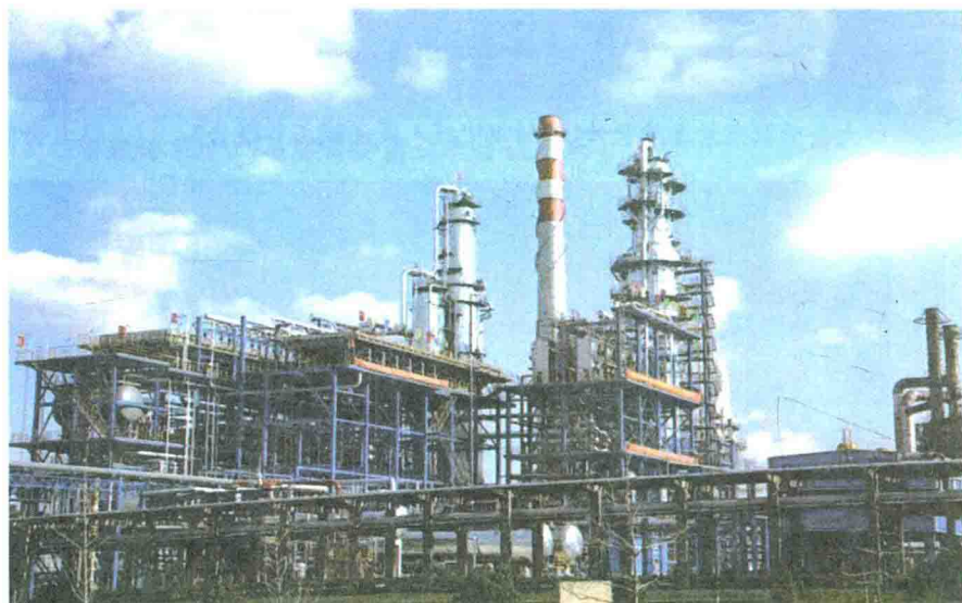
◎中国石化辽阳石化分公司550万吨炼油装置
