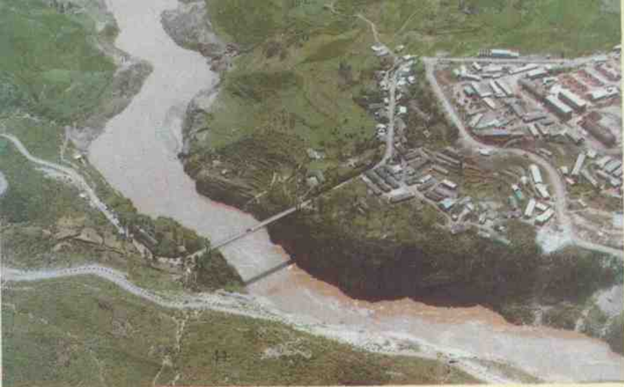
东风电站施工现场鸟瞰
