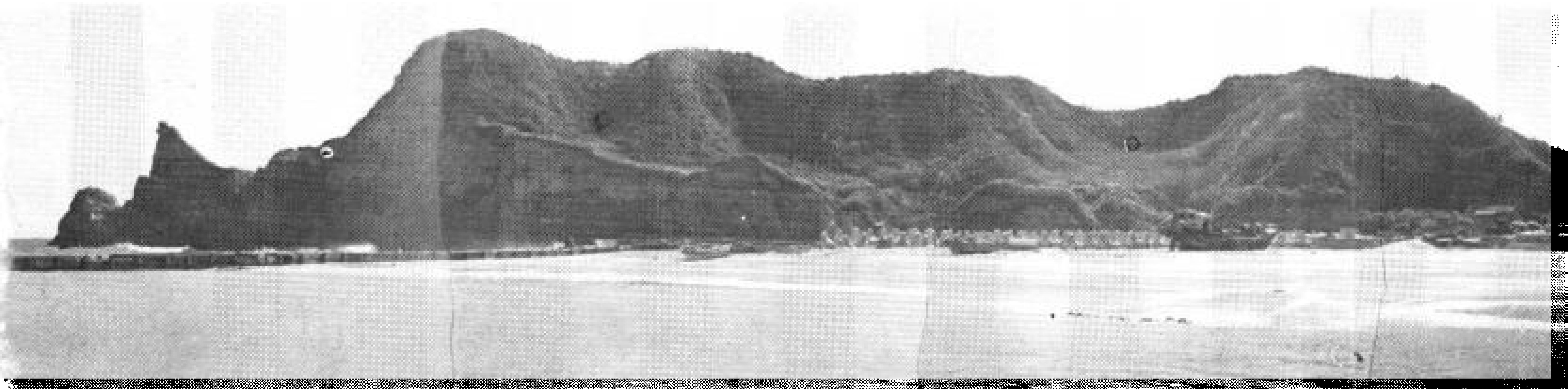
東崎10K陣地付近を北から望む（凹地○印が陣地一九十九里濱側射）
