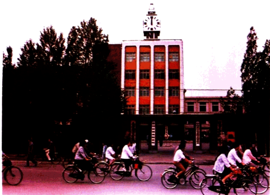
▲金川有色金属公司办公大楼
