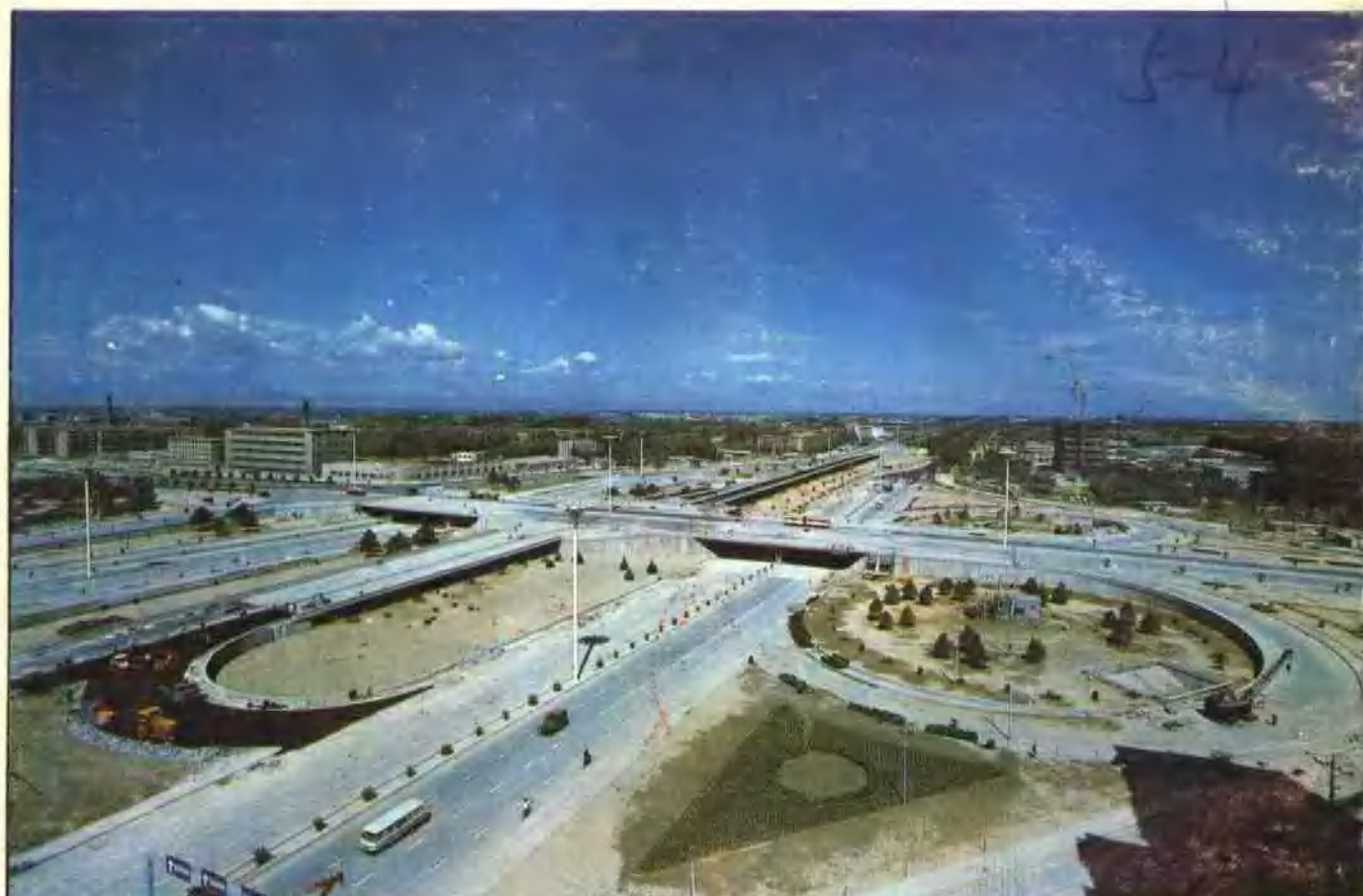
北京市三元立交桥(牛王庙立交桥)
