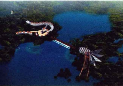
厦门马寮湾湿地生态重构区
