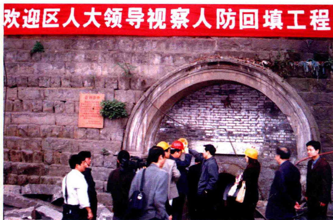
区人大领导视察人防回填处理工程
