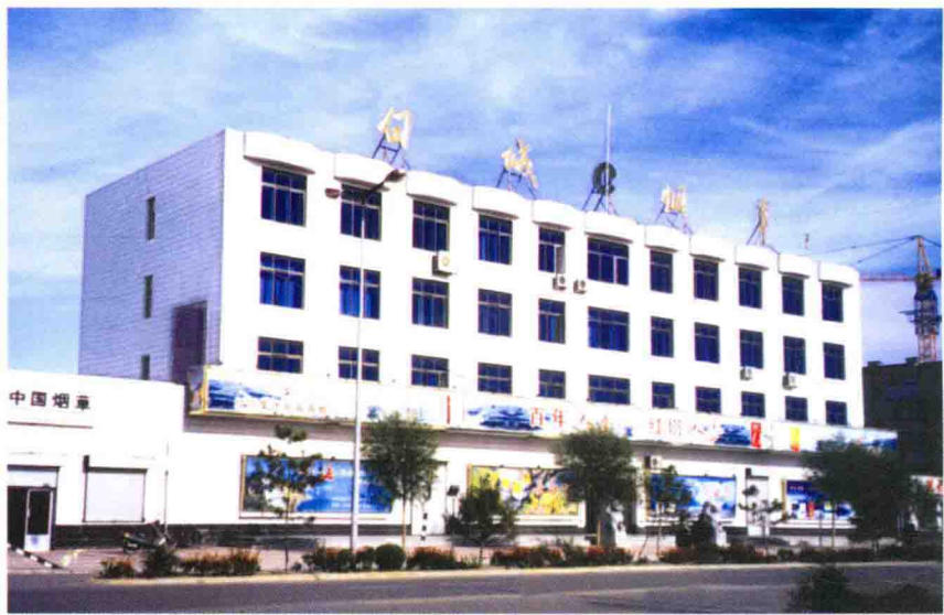
白城市烟草专卖局办公大楼
