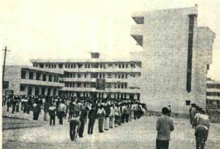
印江三中邵逸夫教学大楼（内景）
