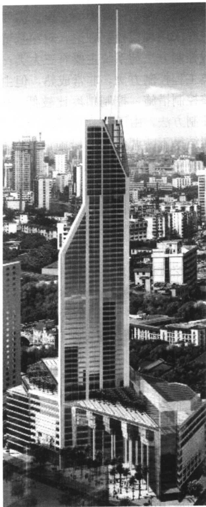
图 2 上海世茂广场
