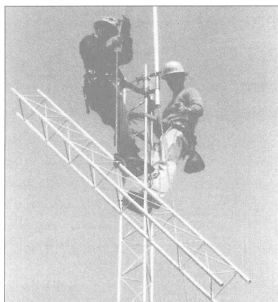
图1-5 当使用起重吊杆将每一个组件吊装至合适的位置时,天线塔零件的组装就变得非常简单了。注意到两个攀登者的安全带都在电杆的下面扣牢,因此可以防止皮带从顶端的部件上滑落。(图片由KIWA提供)
