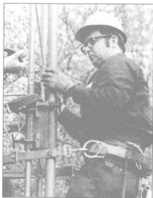
图1-1 Bill Lowry, W1WV使用在天线塔上工作所必需的高质量安全带。安全带应当用大号的钢环作为皮带扣。安全带后部的皮带环应当可以很方便地携带工具。（图片由K1WA提供）
