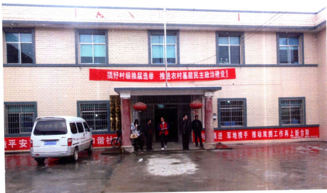
2009年新建的高酿镇人民政府办公楼
