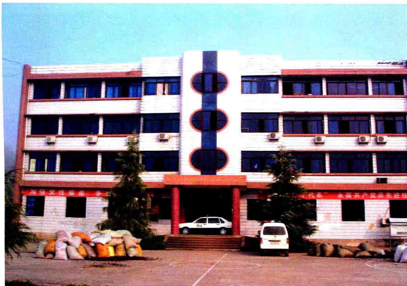
水口镇党委、政府办公楼
