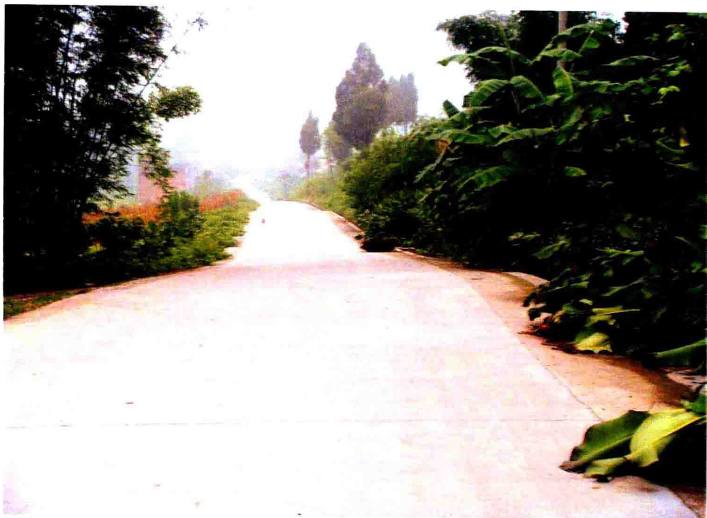
水(口)二(坪)公路
