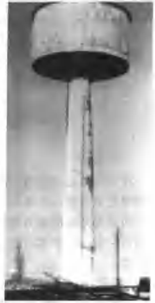
图 1.1.2 这个处于 40 英尺高单混凝土柱上的钢筋混凝土水箱，位于 Valdivia 飞机场附近，在 1960 年 5 月的智利地震中未曾损坏。当水箱充满水时，可将其作为单自由度体系分析。（来自 K. V. Steinbrugge 收藏品，经加州大学伯克利分校地震工程研究中心允许）
