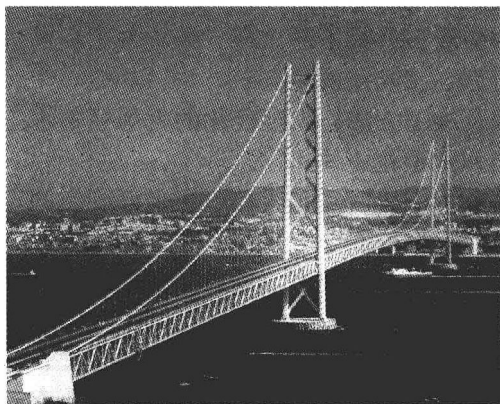
图 1.11 日本明石海峡大桥
