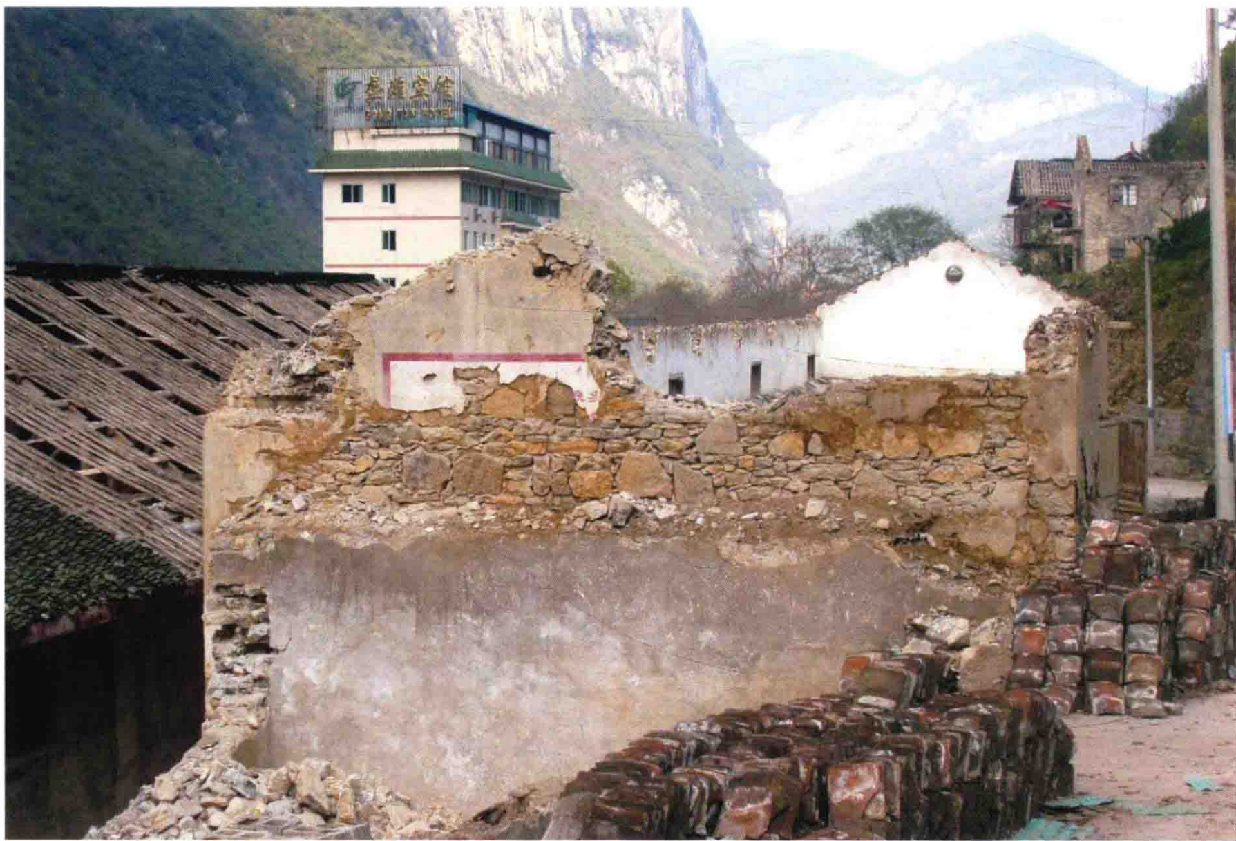
拆迁中的龚滩原貌一角 熊科林摄
