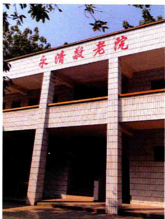
1992 年 1 月永清敬老院修建竣工
