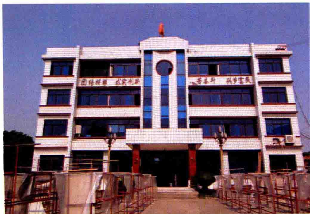
1998年10月新建成的机关办公大楼
