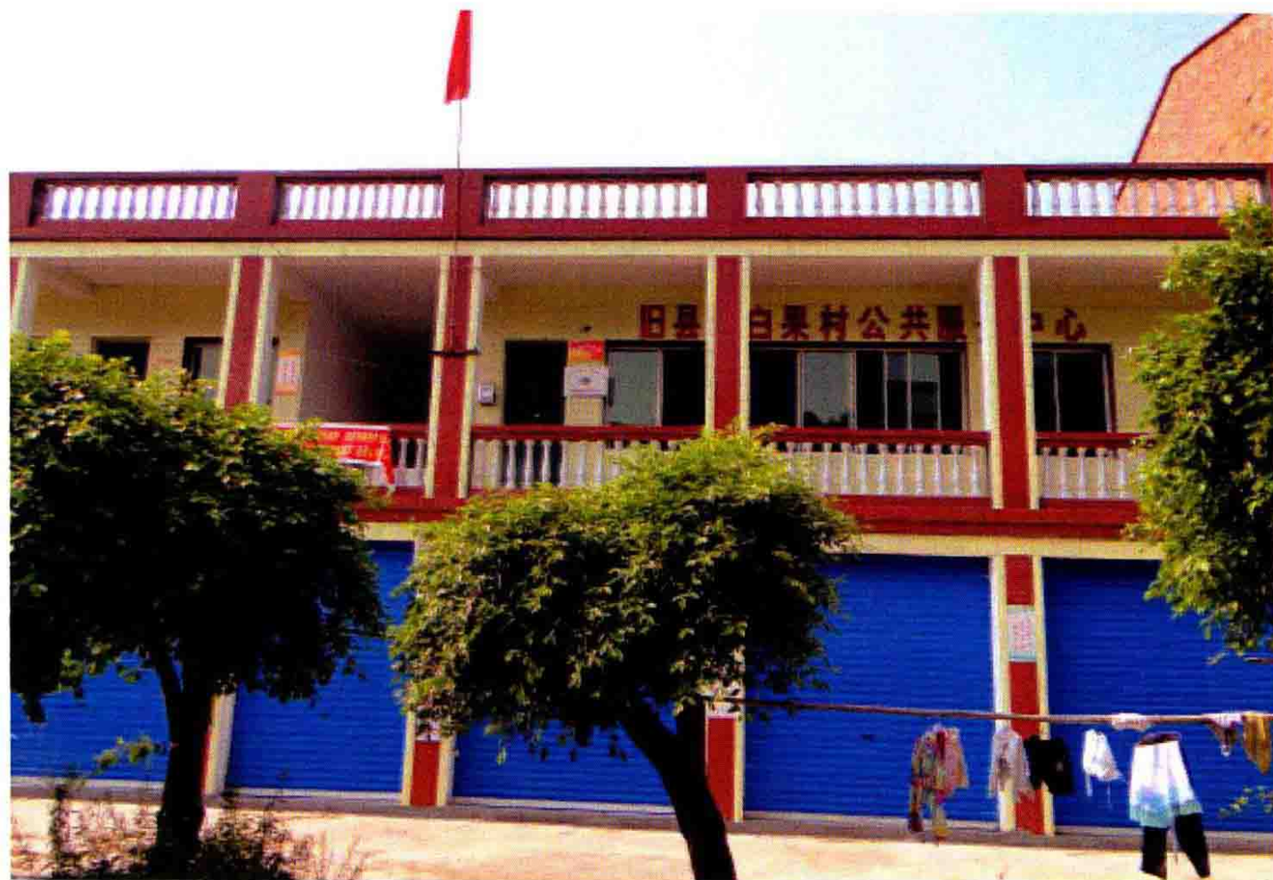
2006 年 8 月修建的白果村村级办公楼
