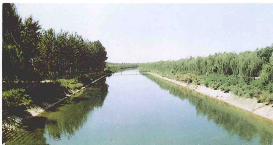
潮河灌区中干渠
