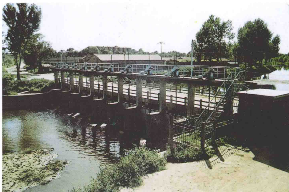
城北减河 10 孔闸桥
