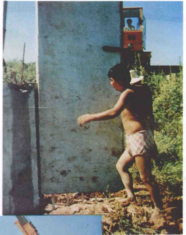
潮白河护岸码头施工采用 “射流沉板”新工艺
