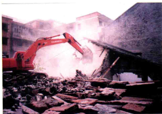
图为巴川镇旧城改造水井巷片区强拆现场。
