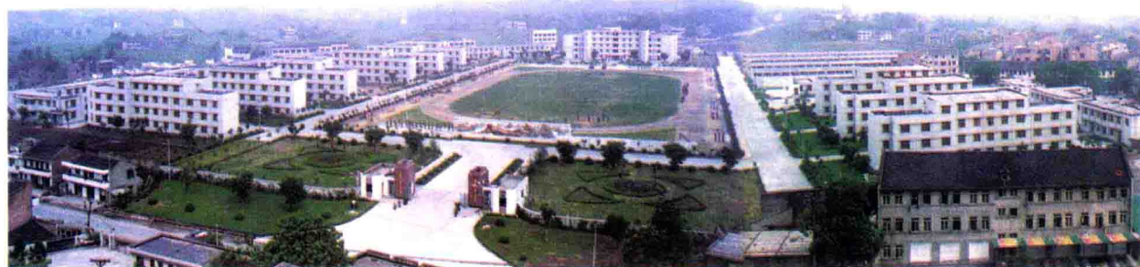
铜梁县军地换地工程——“962”工程全貌
