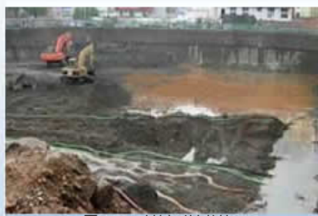
图1-1-4 机械开挖基坑
