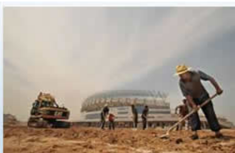
图1-1-2 半机械化场地平整
