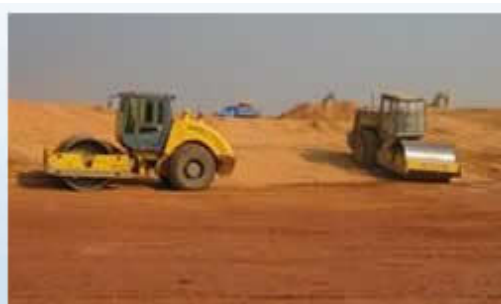
图1-1-1 机械化场地平整
