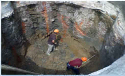
图1-1-3 人工开挖基坑
