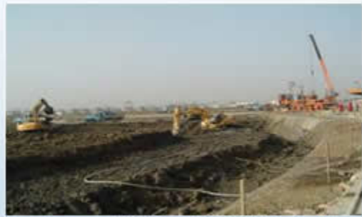
图1-1-6 机械化开挖地下大型土方工程
