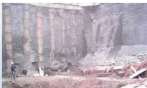
图1-1-5 半机械化开挖地下大型土方工程
