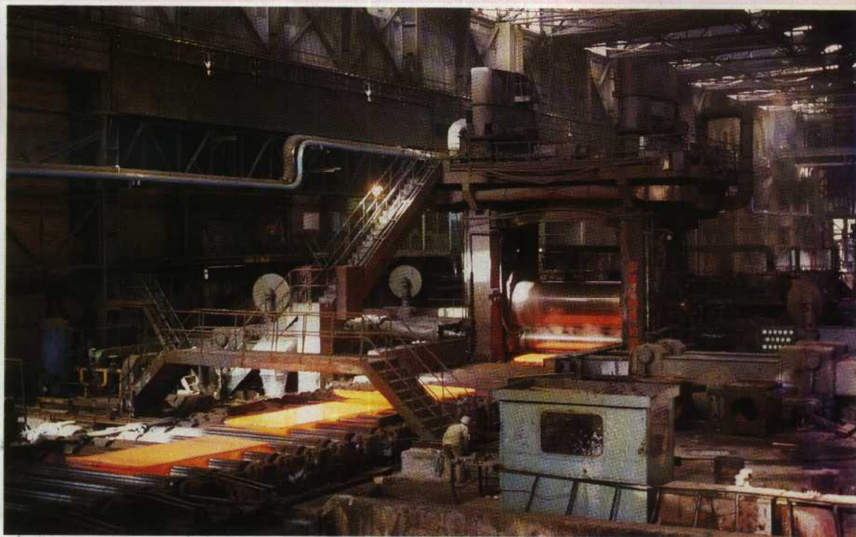
舞阳钢铁公司国内自制的4.2米轧机正在轧制钢材。
