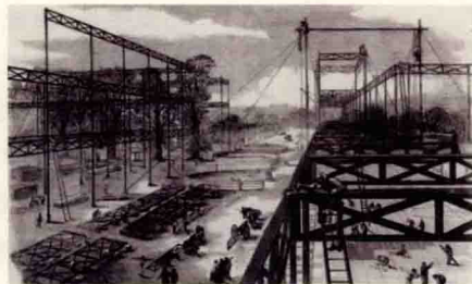
图 1-5 水晶宫玻璃和钢铁预制构件安装
