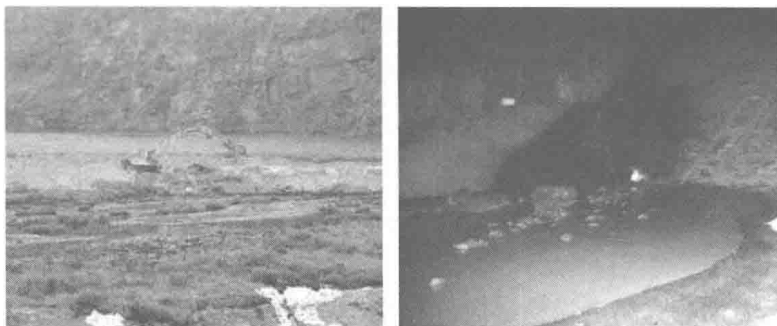
图 1-2 污泥填埋场溃坝及渗漏
