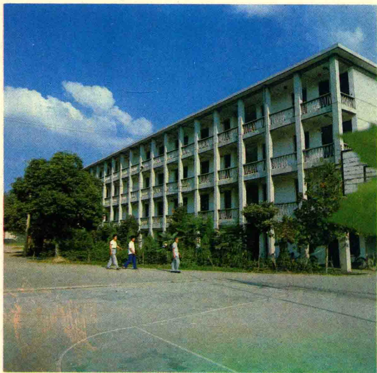
襄樊市第二技工学校教学楼
