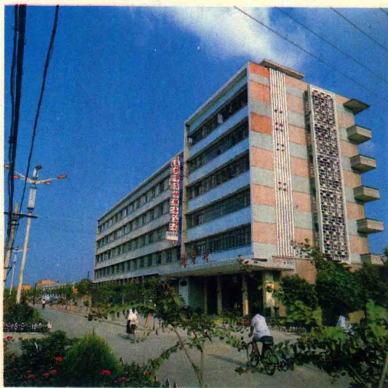
襄樊市劳动服务公司大楼
