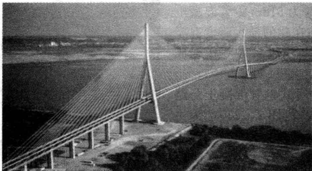
图 1-12 法国诺曼底(Nuomandi)大桥(1995 年)
