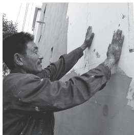
墙壁上贴泡沫板
