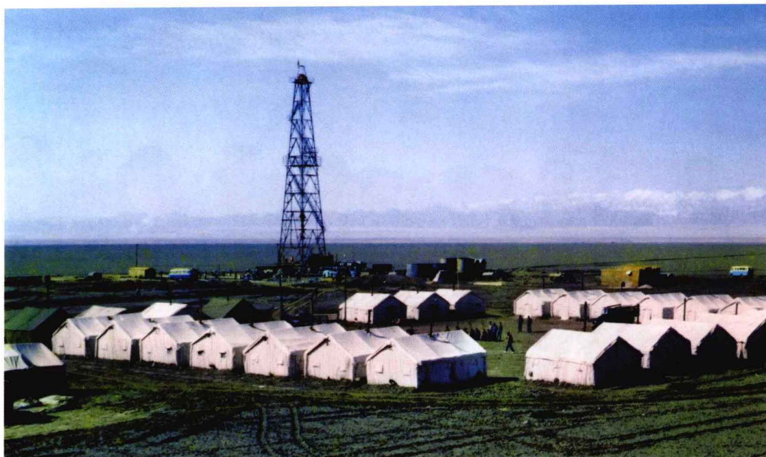
承钻尕斯库勒油田发现井——跃参 1 井的 3288 钻井队施工现场 (青海石油管理局供稿, 1977 年)
