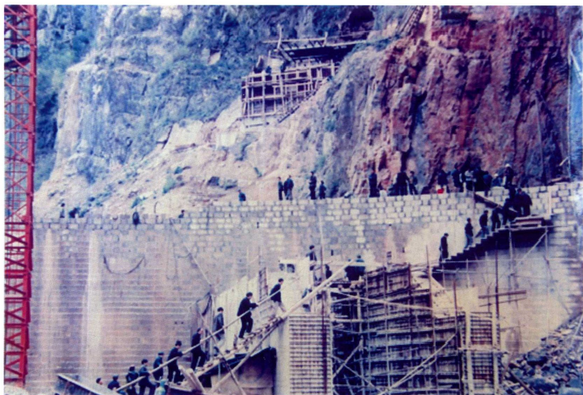
县政协三届一次全体会议期间，委员考察观音岩电站建设工地
